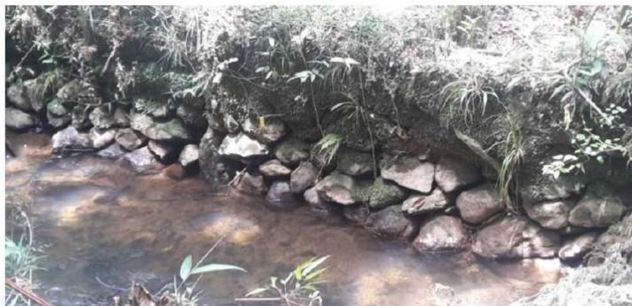
Foto 8. Muros de piedra dispuesto para canalizar pequeños tramos de la quebrada Piedras Blancas. Fuente: (Gómez, 2018-1)
